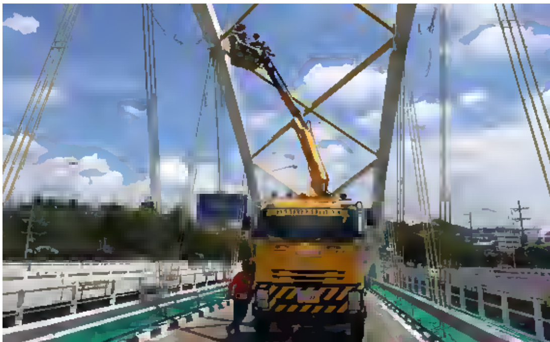
รูปที่ 2-8 การใช้รถกระเช้าสำหรับการตรวจวัดมิติของสะพาน
