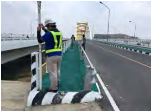
รูปที่ 2-4 การดำเนินงานสำรวจค่าระดับของสะพานเดชาติวงศ์
