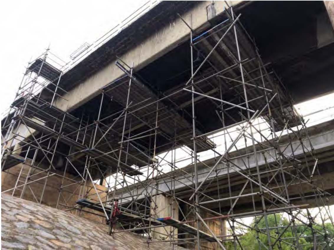
รูปที่ 2-7 การตั้งนั่งร้านสำหรับการตรวจวัดมิติของสะพาน
