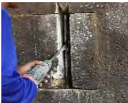
(ซ) การสกัดคอนกรีตที่เหลือเพื่อนำเหล็กเสริมออกมา
