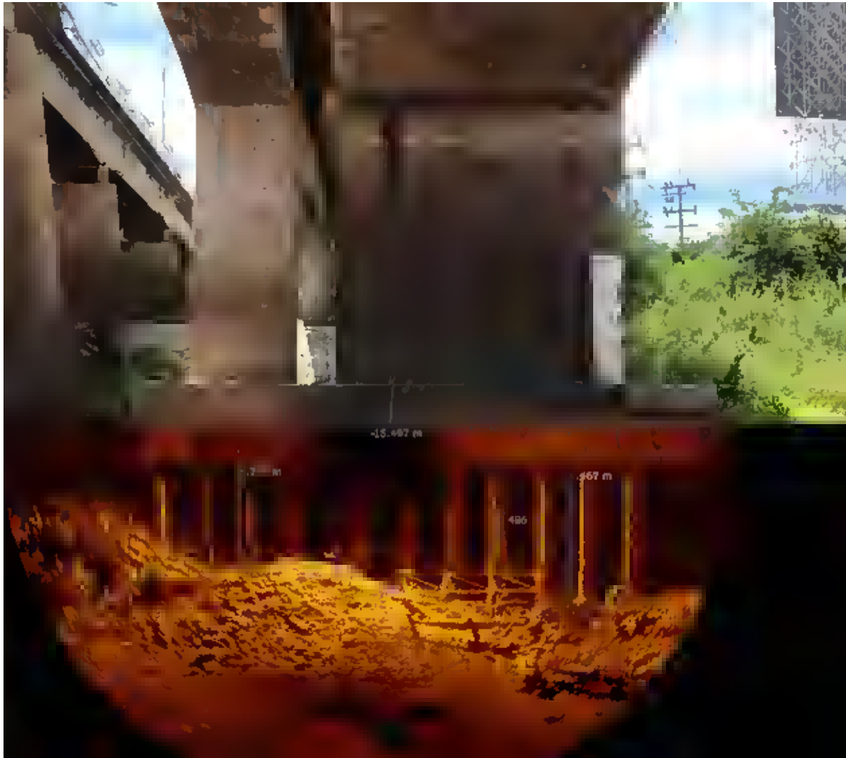
รูปที่ 4-23 ผลการสำรวจการกัดเซาะของดินบริเวณตอม่อ P5 (LT) ด้านนครสวรรค์
