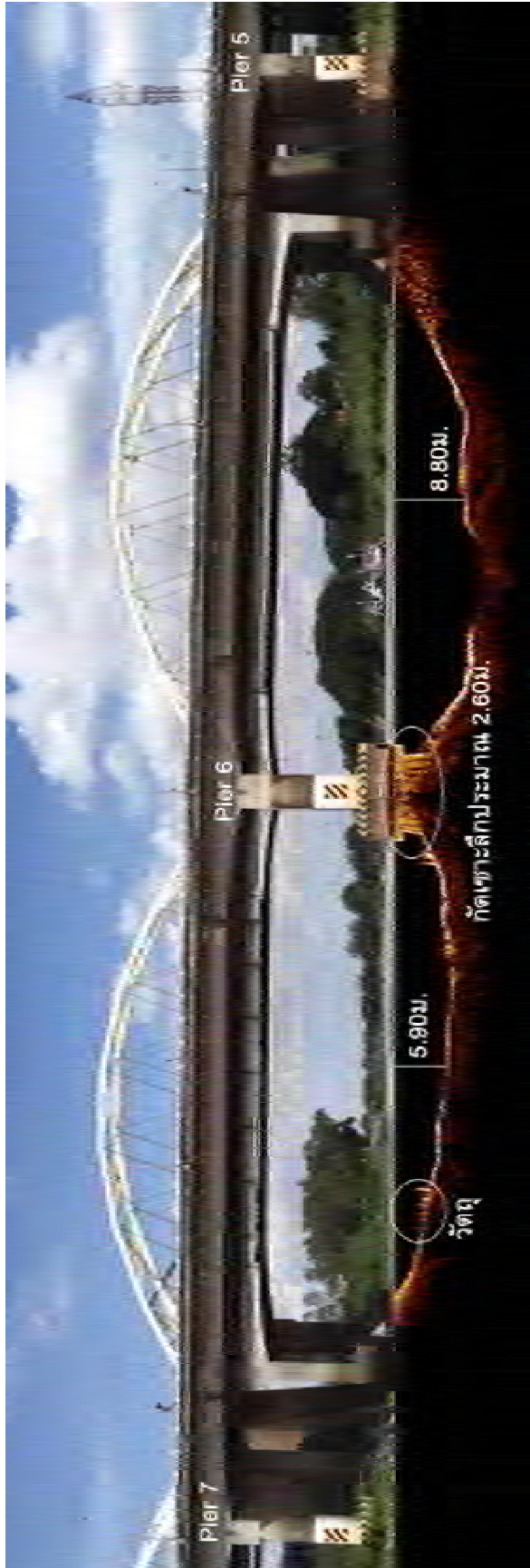
รูปที่ 4-14 ผลการสำรวจระดับร่องน้ำสะพานเดชาดิวงศ์ 2 (สะพาน RT)
