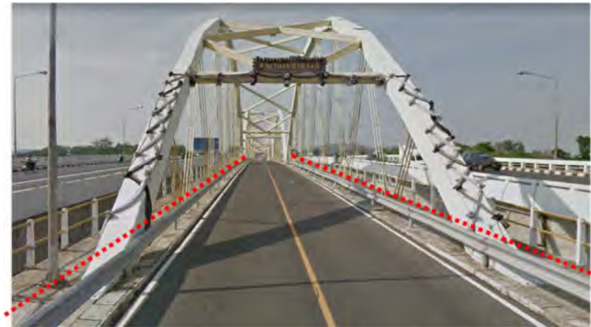
รูปที่ 2-1 แนวที่ใช้สำรวจค่าระดับหลังสะพาน
