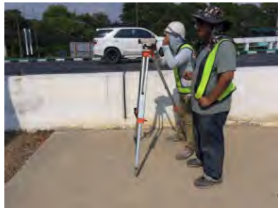
รูปที่ 2-4 การดำเนินงานสำรวจค่าระดับของสะพานเดชาติวงศ์
