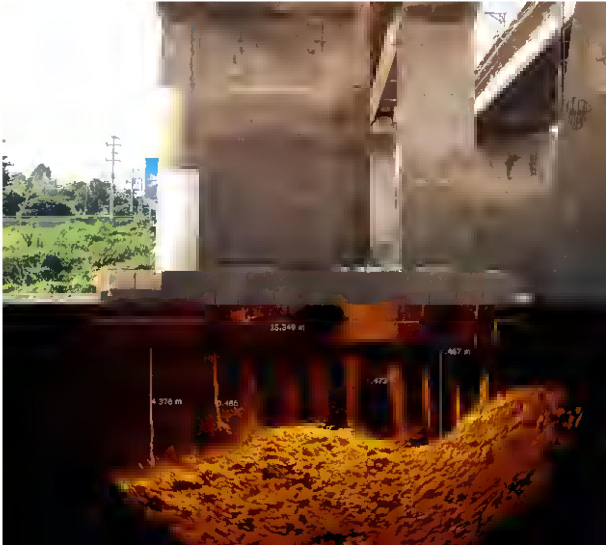
รูปที่ 4-17 ผลการสำรวจการกัดเซาะของดินบริเวณตอม่อ P6 (LT) ด้านกรุงเทพฯ
