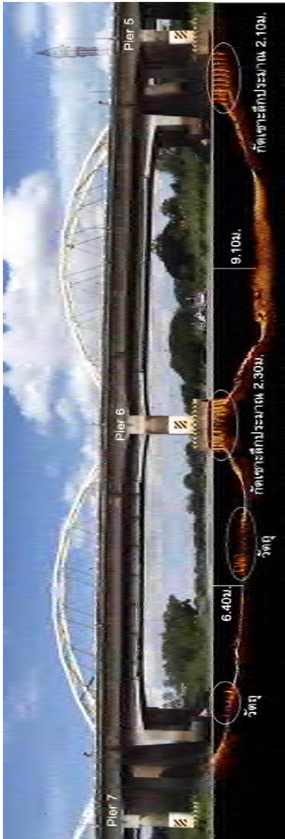
รูปที่ 4-15 ผลการสำรวจระดับร่อนน้ำสะพานเดชาติวงศ์ 3 (สะพาน LT)
